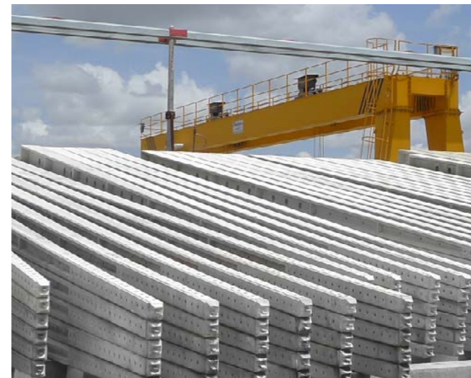
Pré-Fabricação em Betão / Concrete Prefabrication
